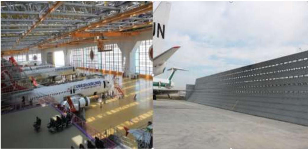
Şekil 1. Uçak bakım-onarım hangarı
