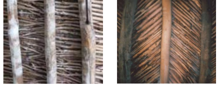
Şekil 23. Bitlis (solda) ve Van (sağda) geleneksel konutlarında döşeme üzerine ağaç dalı uygulama örnekleri (Payashoğlu ve Aksulu, 2016, Erdoğan, 2007).
