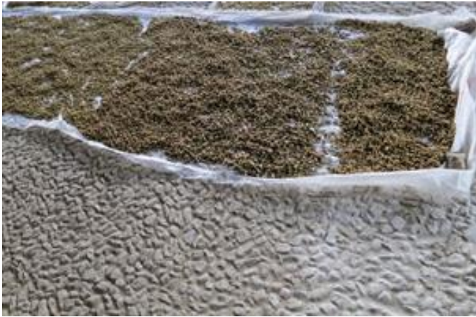
Şekil 21. Erzincan / Kemaliye geleneksel konut düz örtüsünde dere taşı (rıhtım) kaplaması (Akdemir ve Ekşi Akbulut, 2015)
